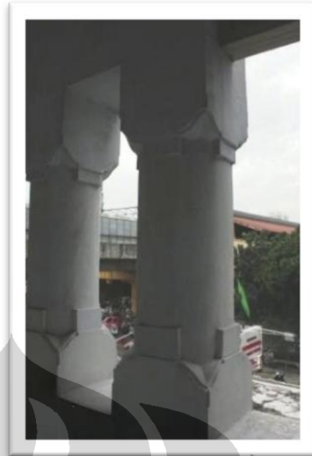
Foto 3.20. Tiang Pendukung di Lantai 2. Sumber : Dokumen Foto Pribadi 2009
