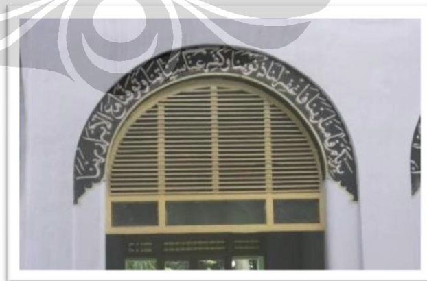
Foto 3.12. Salah Satu Fanlight di Sekeliling Void Lantai 2. Sumber : Dokumen Foto Pribadi 2009
